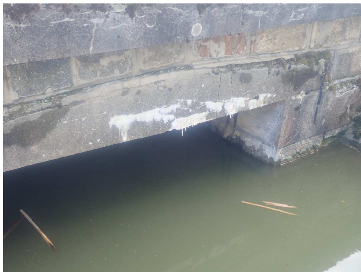
Foto č. 1 Konstrukce K 01 – čelní strana vpravo – průsak vody a pojiva
