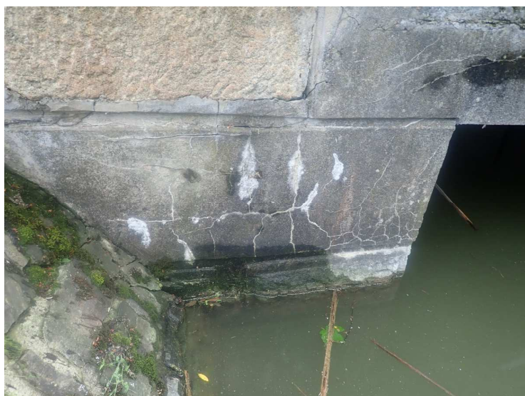
Foto č. 2 Opěra O 01 – úložný práh zprava – průsak vody a pojiva
